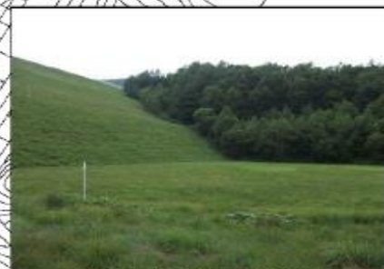
堤体下流面地山境界部 (左岸側)
