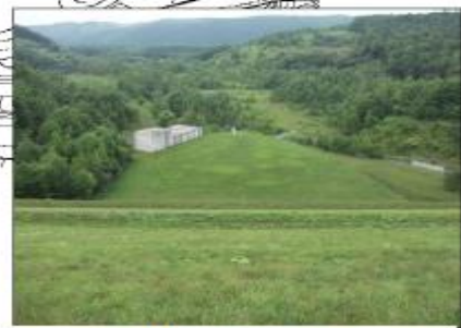
堤体下流面全景
