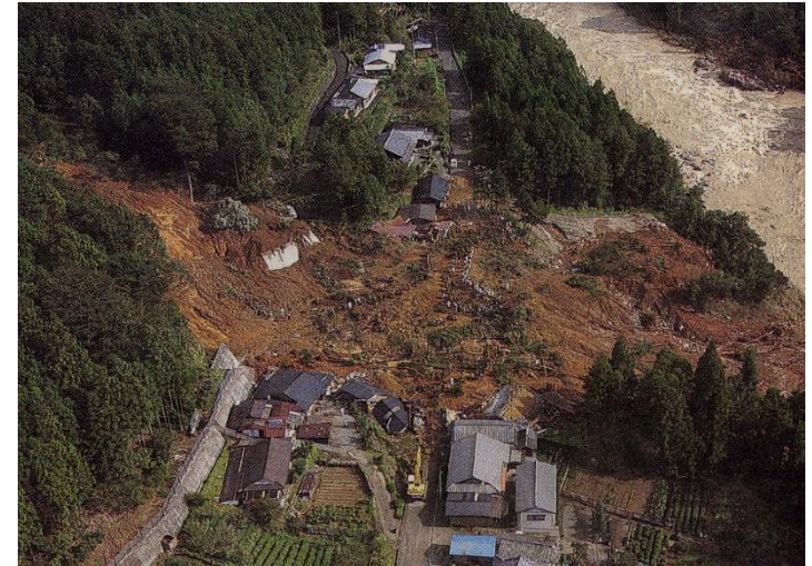
平成16年 台風21号による斜面崩壊
