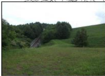
堤体下流面地山境界部 (右岸側)
