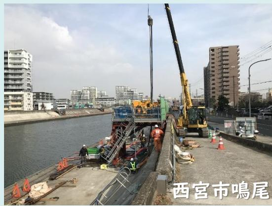
②高圧噴射攪拌工法
