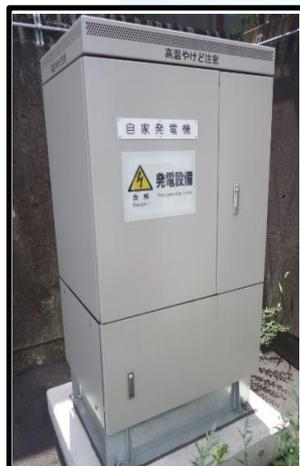
自家発電装置:停電時、陸開開閉用モーターや機側操作盤に電源を供給する。
