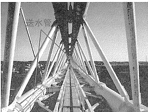
写真-2. 2 那珂川水管橋 断面
