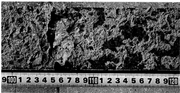
写真-2 はく離箇所の接着界面状況 (HT600 供試体)
