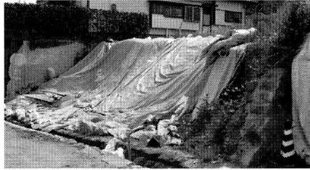
写真-1.2 ひな壇部分の変形・崩壊被害
