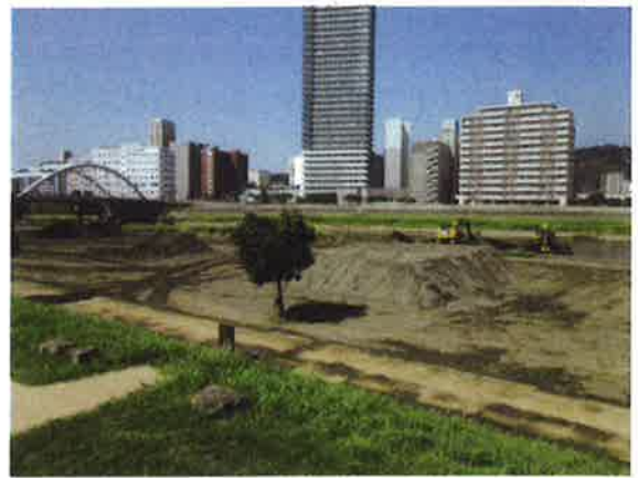
写真-47 白川橋付近で行われていた浚渫作業
