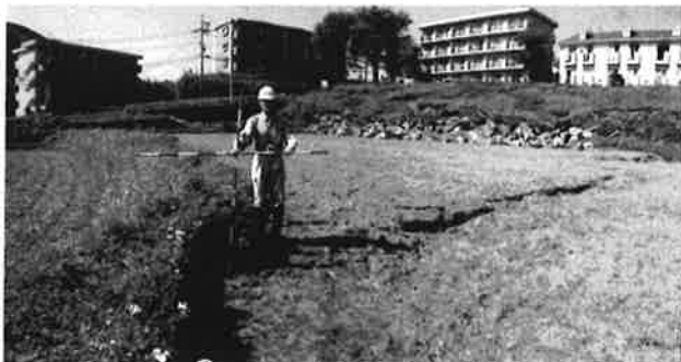
写真-26 河陽地区に出現した断層変位
