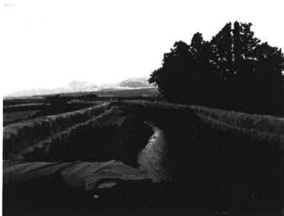
写真-14 大型土嚢による嵩上げ（乙姫川）
