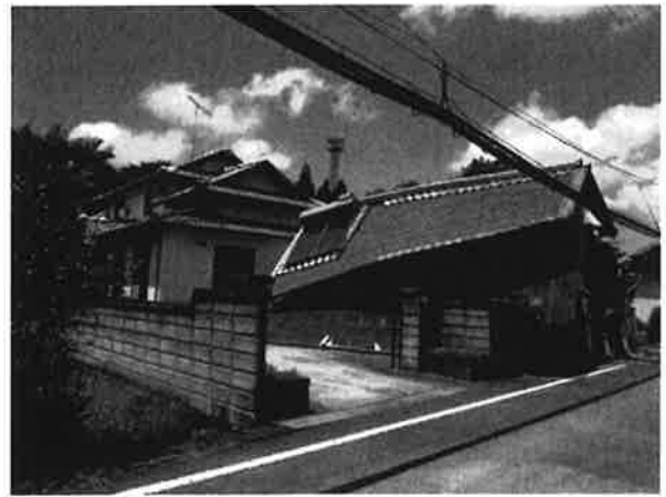
写真-31 断層変位近傍の倉庫の被災
