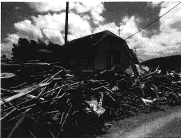
写真-35 中段の状況②
