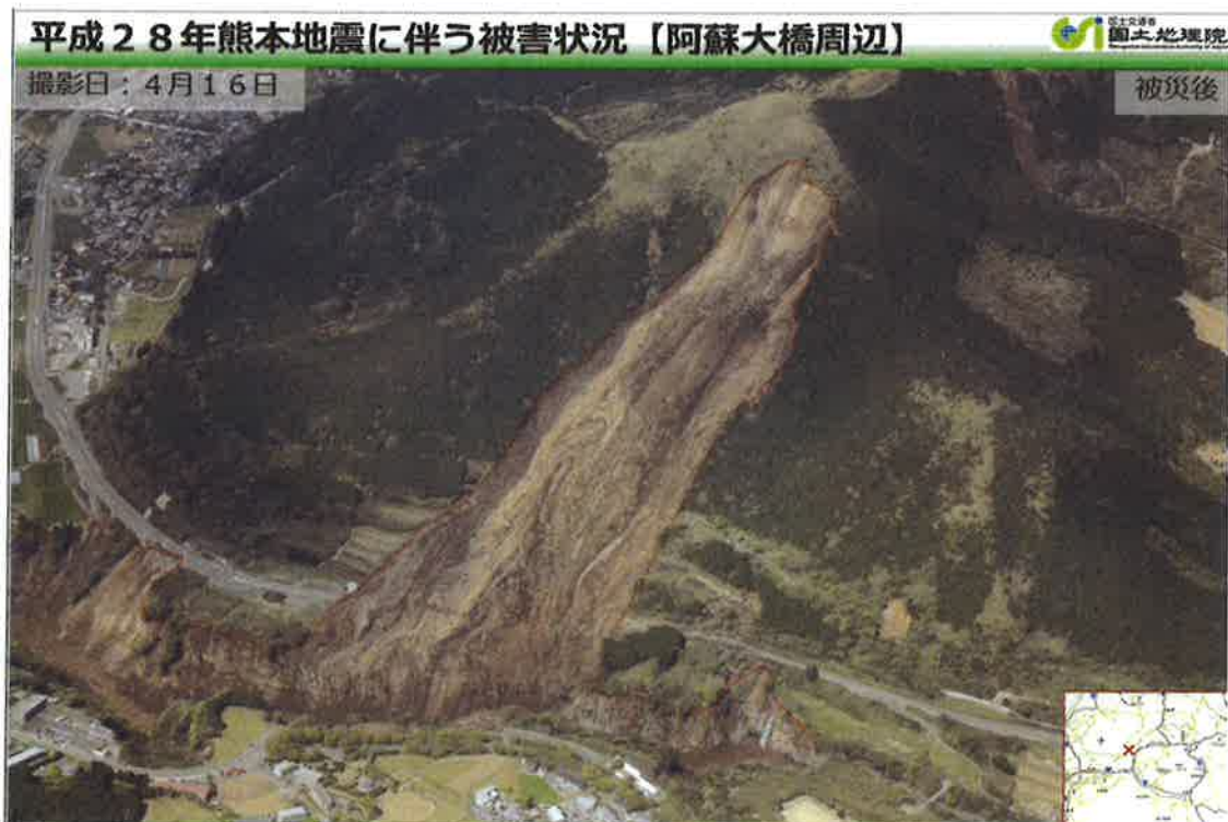
写真-24 本震直後(4月16日)の阿蘇大橋周辺の大規模崩壊 19)
