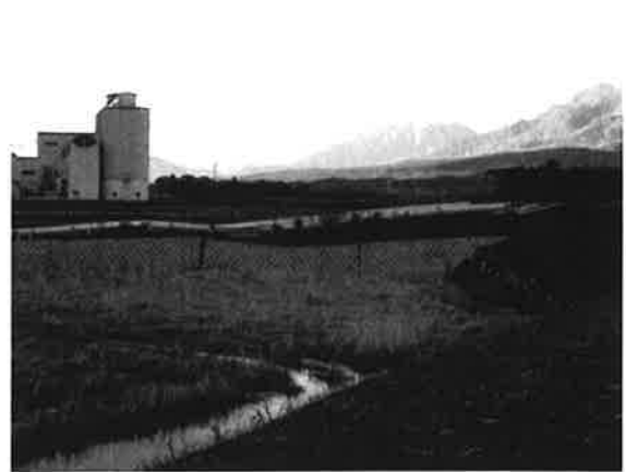
写真-13 C地点の河川取り付け道路ブロックの変形
