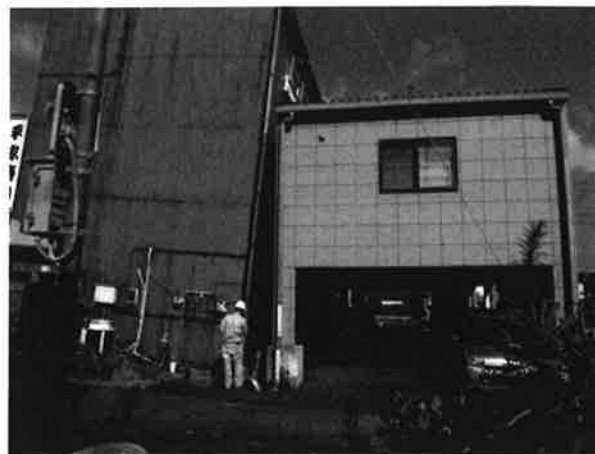
写真-40 液状化による建物の傾倒(刈草一丁目)
