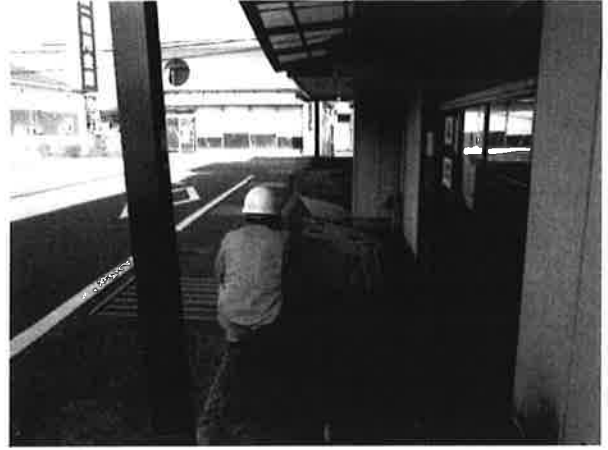
写真-42 液状化によるRC建築物の沈下 (刈草一丁目)
