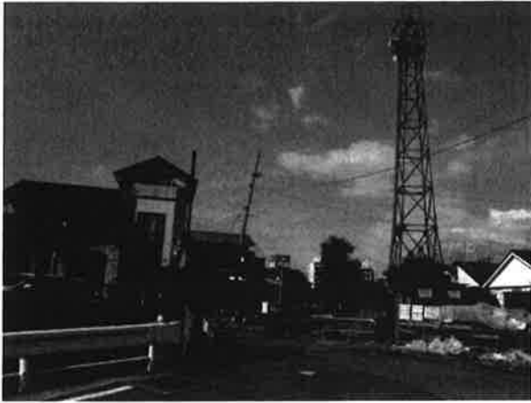
写真-41 電柱の傾き (刈草一丁目)
