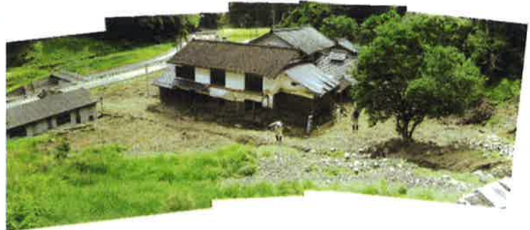
写真-2 土石流による被災状況 (兵庫県提供)
