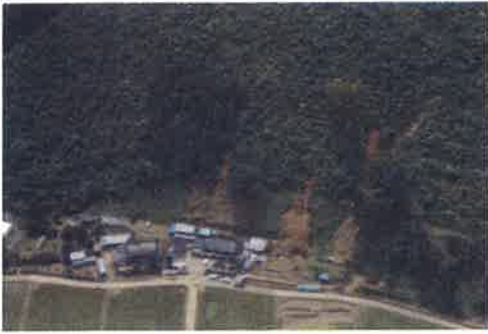
写真-1 山腹崩壊の状況 (兵庫県提供)
