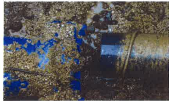
(l) 曲管 22.5° HIPV φ75 抜け漏水
