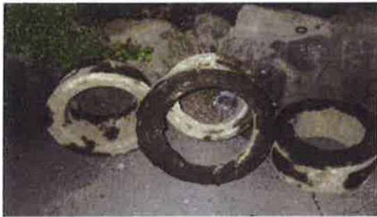
(c) 上図(b)のバルブBOX破損
