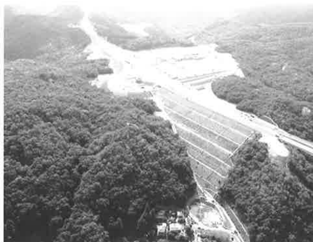
図-5. 1 宝塚北 SA 完成後全景
