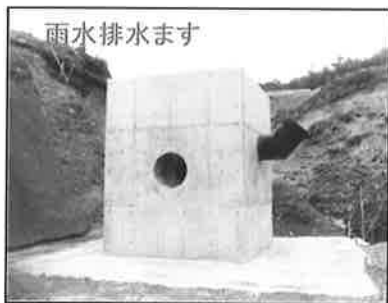
写真-4. 2 雨水排水ます、地下排水工、雨水排水工施工状況
