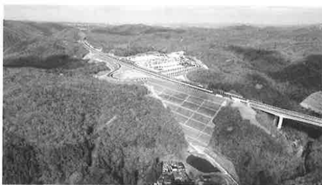
写真-4.6 高盛土と調整池
