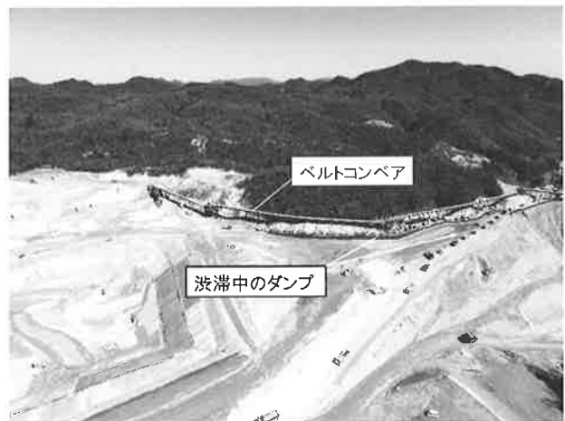
写真-4. 8 ベルトコンベアによる土運搬
