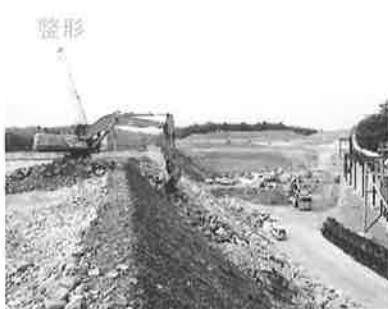
写真－４．３ 垂直排水層施工状況
