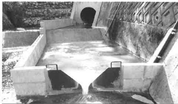
写真-4.7 流量測定用の三角堰
