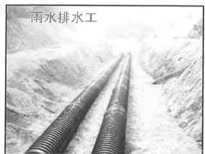
写真-4. 2 雨水排水ます、地下排水工、雨水排水工施工状況
