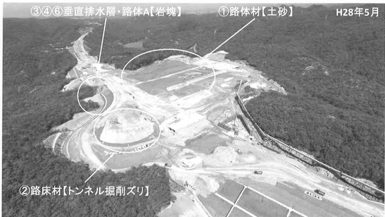
写真-4. 9 盛土材料の仮置き状況
