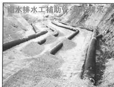
写真-4. 2 雨水排水ます、地下排水工、雨水排水工施工状況
