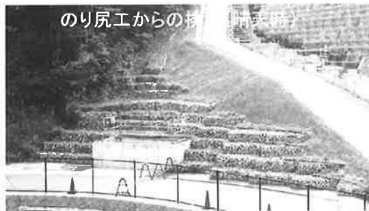
写真－４．５ 法尻工施工状況
