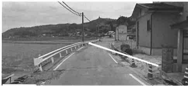
図-1 4 下陣の管路横断周辺の調査地域の様子
