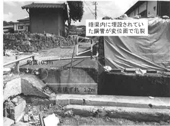
図-17 水路横断部での断層変位
