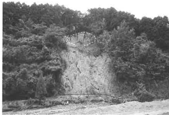
写真-9 朝倉市赤谷川沿いで見られた遷急点を含む崩壊 25)
