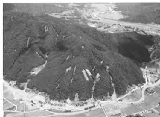
写真-7 丹波市市島町における土砂災害 (国際航業提供)
