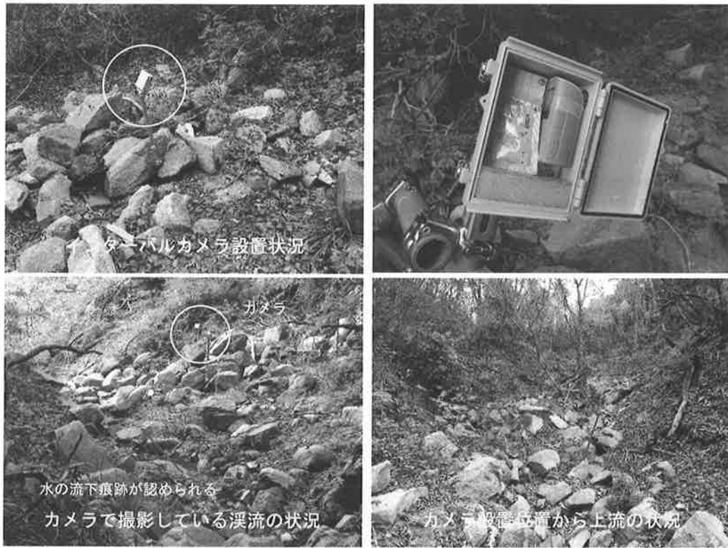
写真-12 インターバルカメラ設置状況
