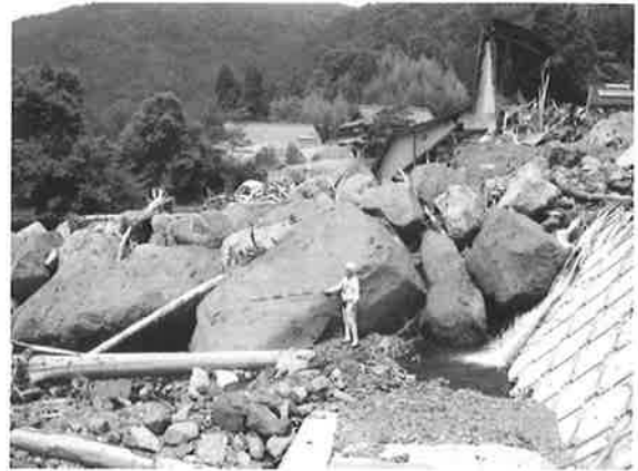
写真-2 流出した巨石（矢ヶ部氏提供）
