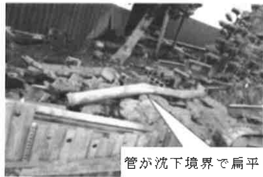
図-13 谷川断層におけるUV下水渠の陥没被害
