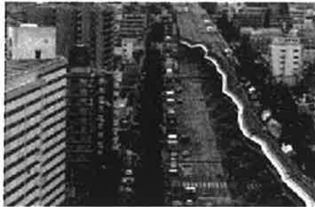
図-2 高速道路の倒壊
