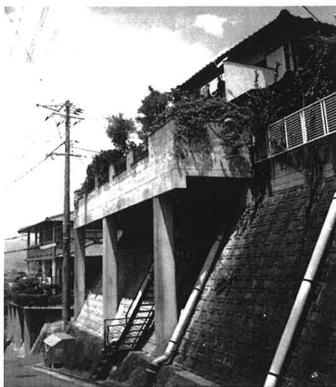
写真-9 口田南3丁目で見られた造成擁壁
