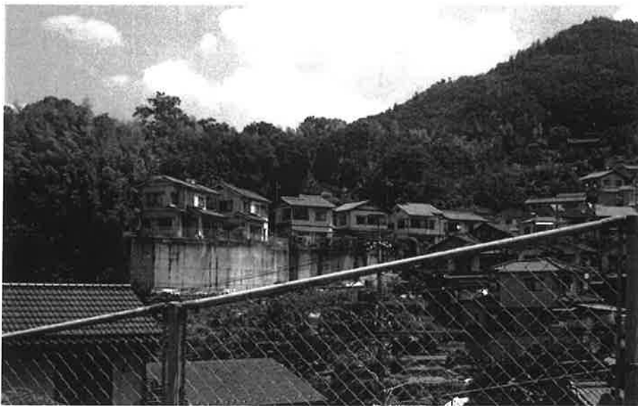
写真-4 コンクリート擁壁上の住宅
