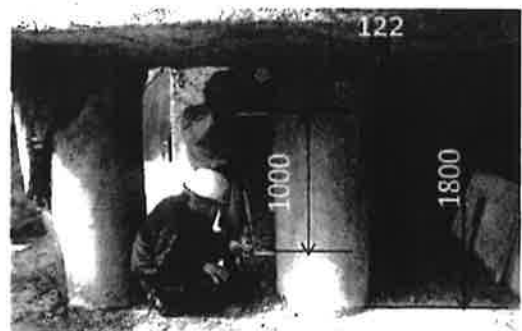
図-3.2(a) 基礎杭の破壊
