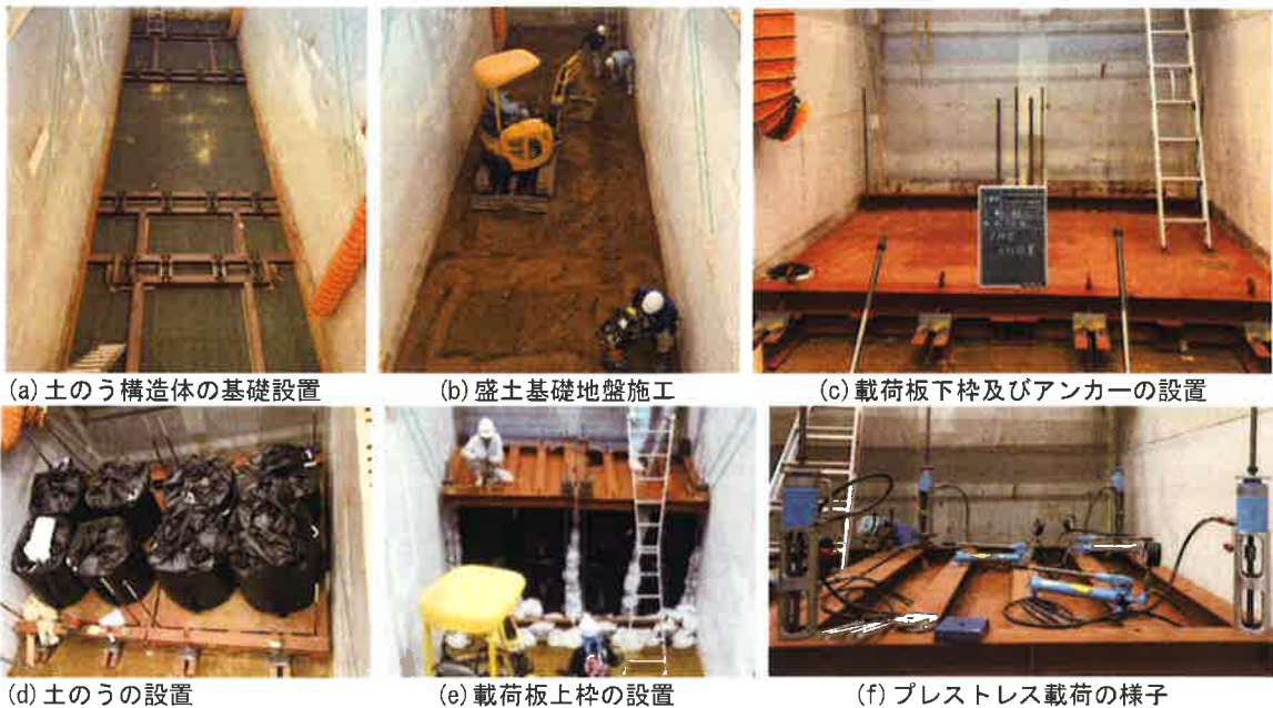
写真-2 土のう構造体施工の様子
