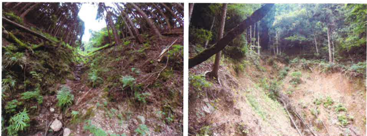
写真 2 狭窄部の状況ならびに崩壊地滑落崖周辺の状況 (360 度カメラで撮影)
