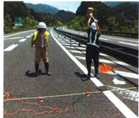
写真-3 表面波探査実施時の様子
