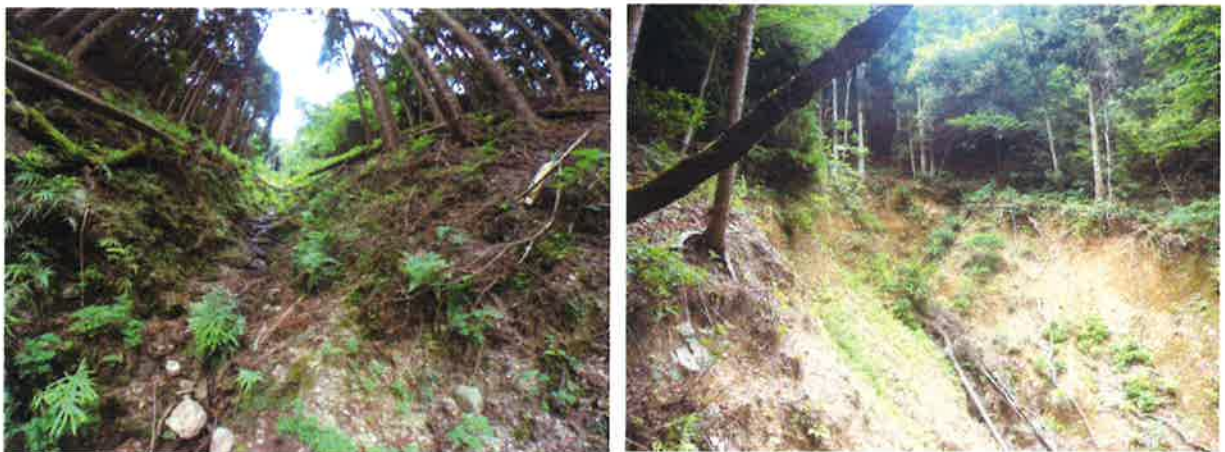
写真2 狭窄部の状況ならびに崩壊地滑落崖周辺の状況 (360度カメラで撮影) 4)
