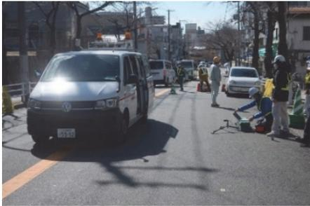
写真-1.1 FWD と OCM による計測状況
